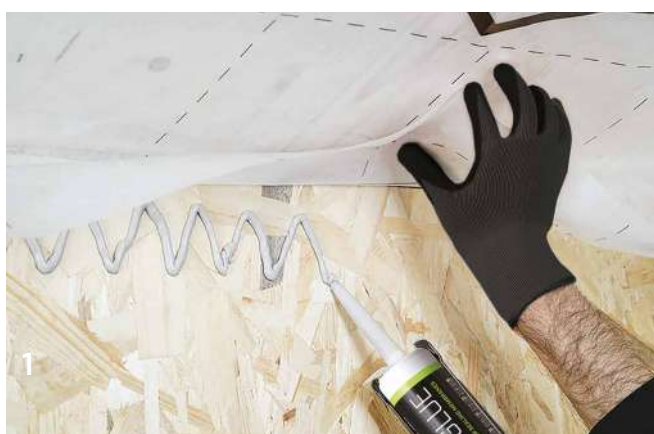
УСТАНОВКА МЕМБРАНЫ НА OSB ОСНОВАНИЕ
