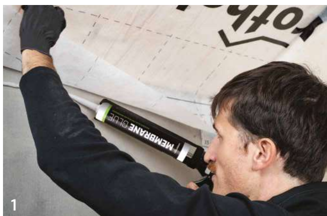
УСТАНОВКА МЕМБРАНЫ НА БЕТОННОЕ ОСНОВАНИЕ
