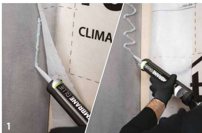
УСТАНОВКА МЕМБРАНЫ НА СТЕНУ - БЕТОН
